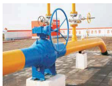
全焊接球阀使用在西部天然气工程 Fully welded body ball valve in west natural gas project
